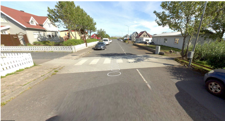
Mynd 3.7 Gangbrautarmarki D02.11 vantar við gangbraut.
